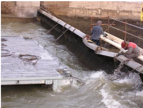
Príklad po kodenia horných vrát spôsobených nárazom lode
