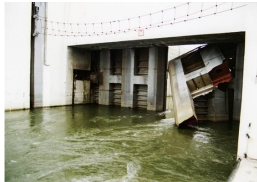
Príklad po kodenia dolných vrát (únava materiálu) z 90tych rokov minulého storočia
