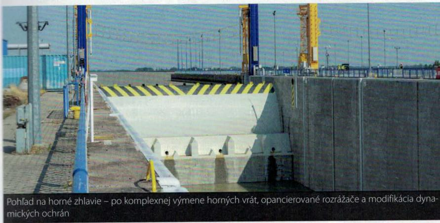
Pohľad na horné zhľavie – po komplexnej výmene horných vrát, opancierované rozrážače a modifikácia dynamických ochrán
